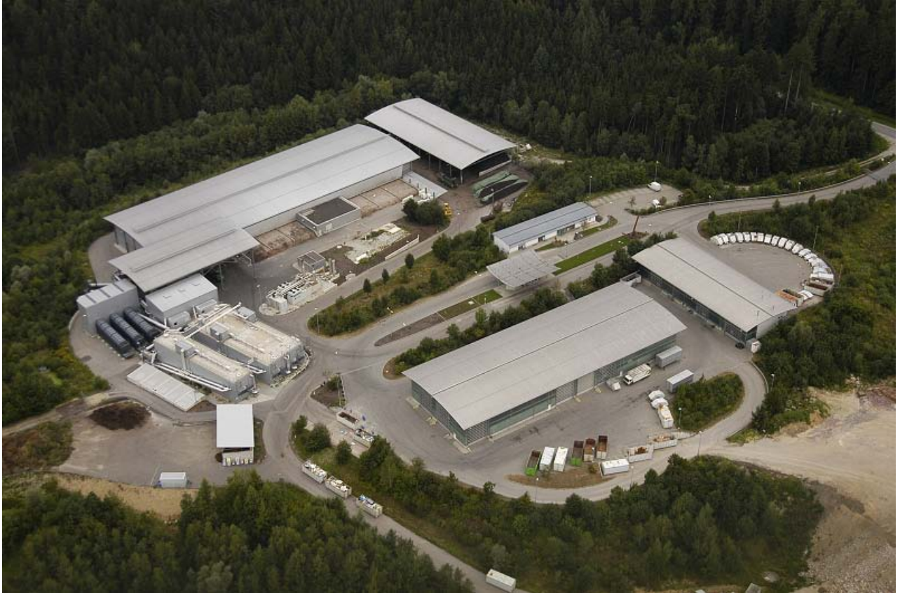
Planta de biogás de la empresa Thöni/Kompostgas en Passau, Hellersberg, Alemania.
